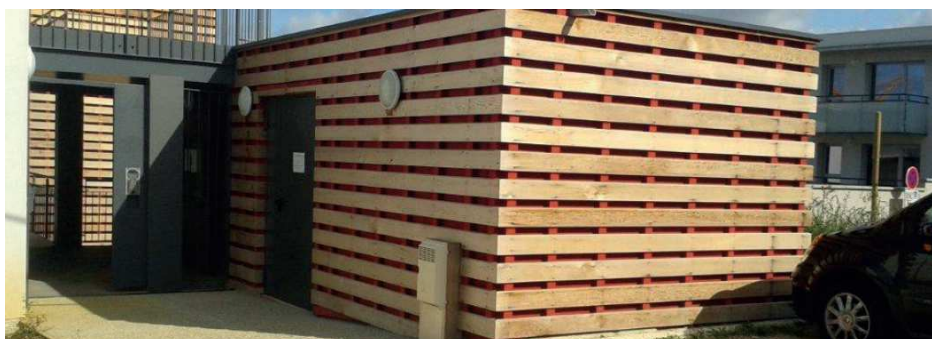
Exemple de point de regroupement extérieur couvert
